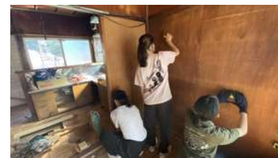
芝浦工業大学公認サークル 空き家改修
